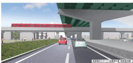
主要地方道岐阜稲沢線(西尾張中央道)と名鉄尾西線の交差部において、鉄道による踏切遮断と、前後区間で4車線から2車線への車線減少による慢性的な渋滞を解消するため、鉄道高架化を行おうとしている。これにより、岐阜稲沢線を始めとして3箇所の踏切がなくなり、新たに3箇所の交差道路が整備される予定。鉄道高架を整備するにあたって、これまで仮側道整備をするための借地交渉を行ってきた。この借地用地の確保がほぼ最終段階に至り、仮側道の整備が始まる準備が整いつつある。来年から仮側道の工事と同時に、観音寺駅から東の鉄道工事の準備が進められる。
