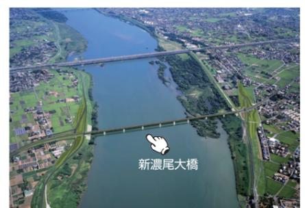
濃尾大橋の渋滞緩和と岐阜県との地域間交流を図るため、一宮市と羽島市間に新しい橋の整備を進めてきた。既に木曾川の両岸に橋台がそれぞれ1基、川の中に橋脚が5基完成しており、現在、残る橋脚3基の施工に取り掛かっている。新たに橋梁上部工(橋長L=759m)が始まる予定で、今年には愛知県側の335.4mの桁製作に着手し、順調にいけば2020年代半ばに完成予定!
